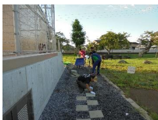
【平板ブロックのアプローチ完成】
