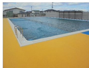
【完成したプール】
