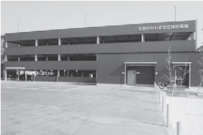
▲かわまち立体駐車場
