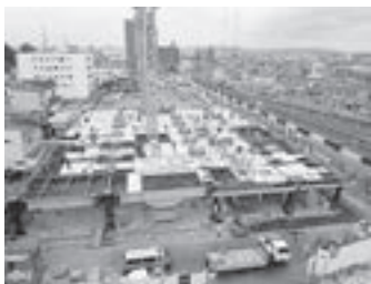
▲建設中の石巻市立病院
