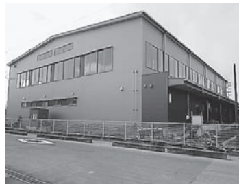
▲新築された向陽小学校体育館
