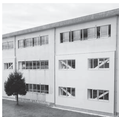
▲耐震補強工事が終了した桃生中学校
