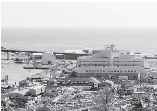
▲被災した石巻市立病院（南浜町）
