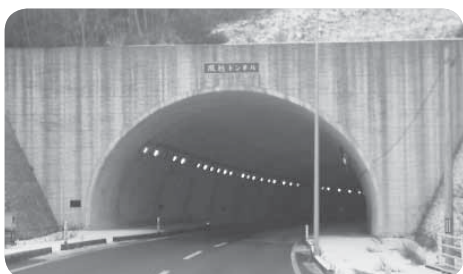
◀風越トンネル
