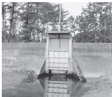
北上地区の水門
