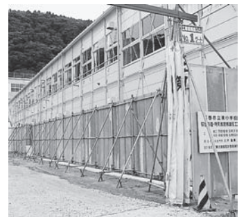
校舎改造工事が行われている湊小学校
