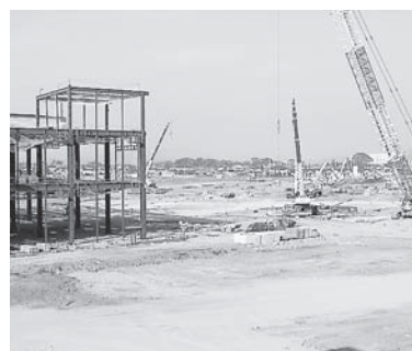
大型店の建設が進む蛇田西部土地区画整理
