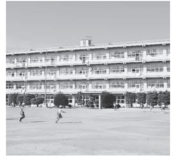
システムが設置されている釜小学校
