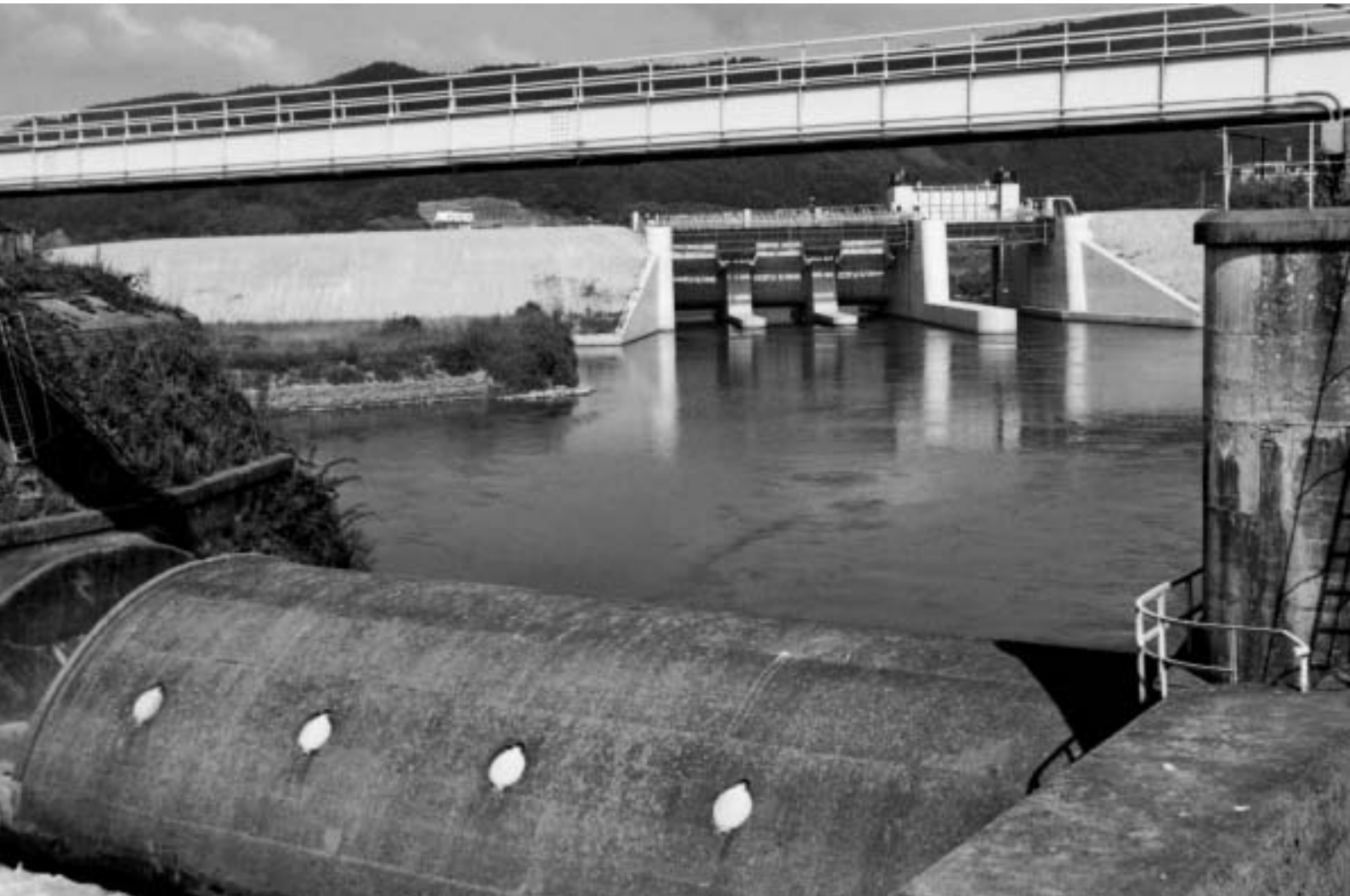
脇谷洗堰(手前)と新水門(奥)… 桃生町
