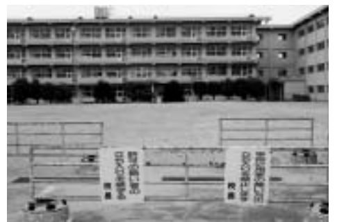
通用門を閉めている学校
