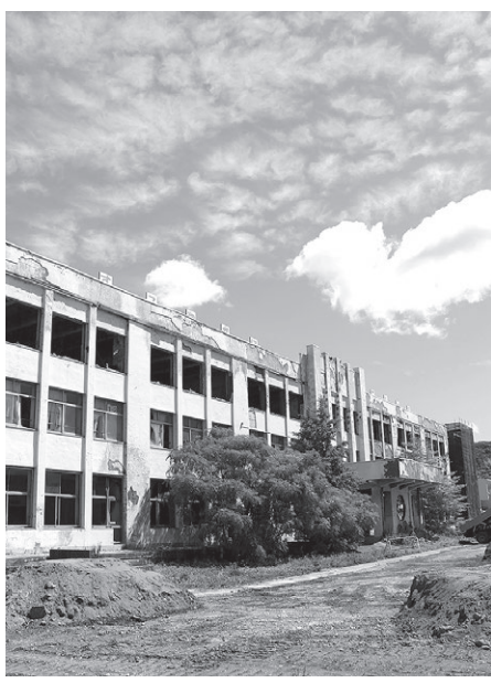
震災遺構門脇小学校 (令和3年7月時点)
