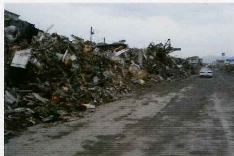
▲南浜町の被災状況(3月21日撮影)
