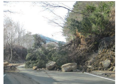
通行止めになった道路（牡鹿半島）
