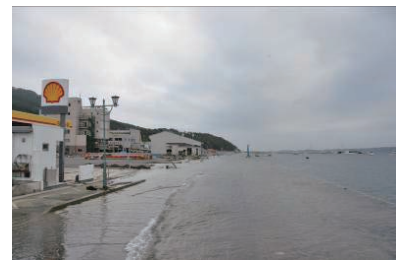
1m以上の地盤沈下（鮎川港）
