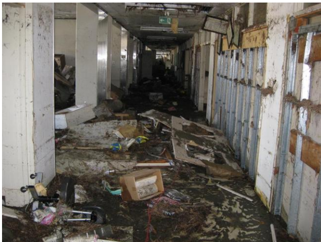
地震から3日後（校舎内部の状況）
