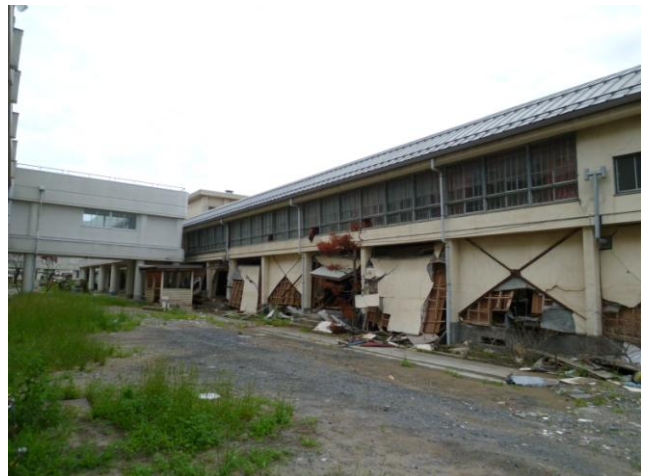
4か月後の状況（復旧は困難）
