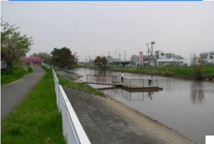
漕艇用の浮き棧橋
