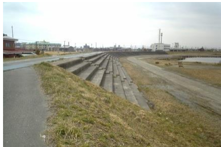
堤防の川側 階段が整備され、河川をゆつくり見ることができる
