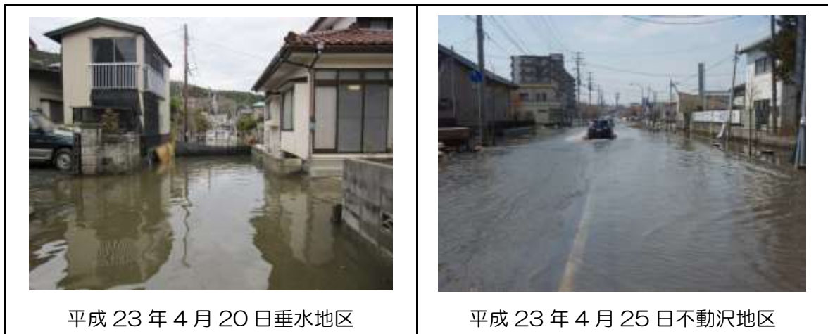
図 2-14 仮堤防設置前における満潮時の浸水範囲と仮設ポンプ設置状況
