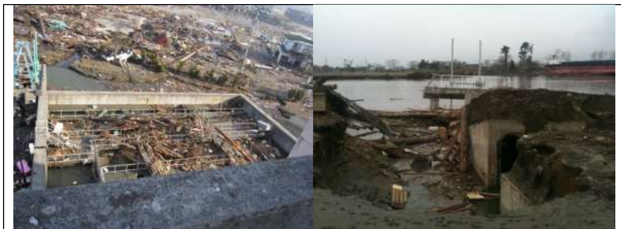
図 2-5 雨水施設の被害状況
