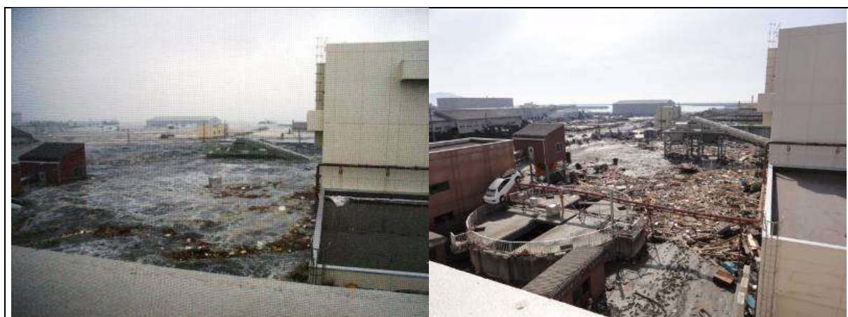
図 2-7 石巻東部浄化センターの被害状況(宮城県 HP より)
