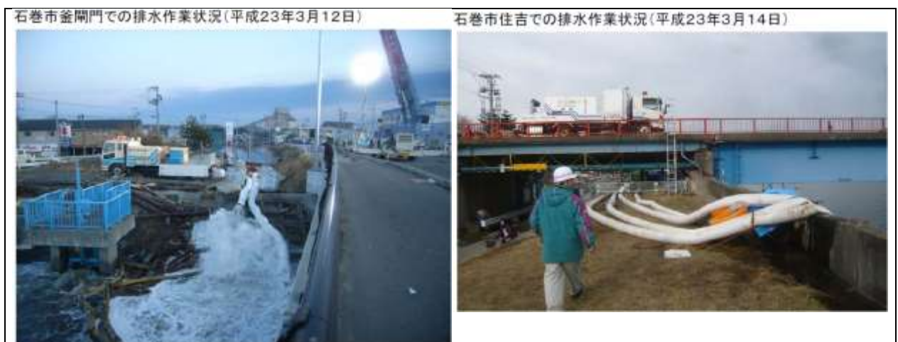
図 2-11 国交省の排水ポンプ車による排水(国交省発表資料)
