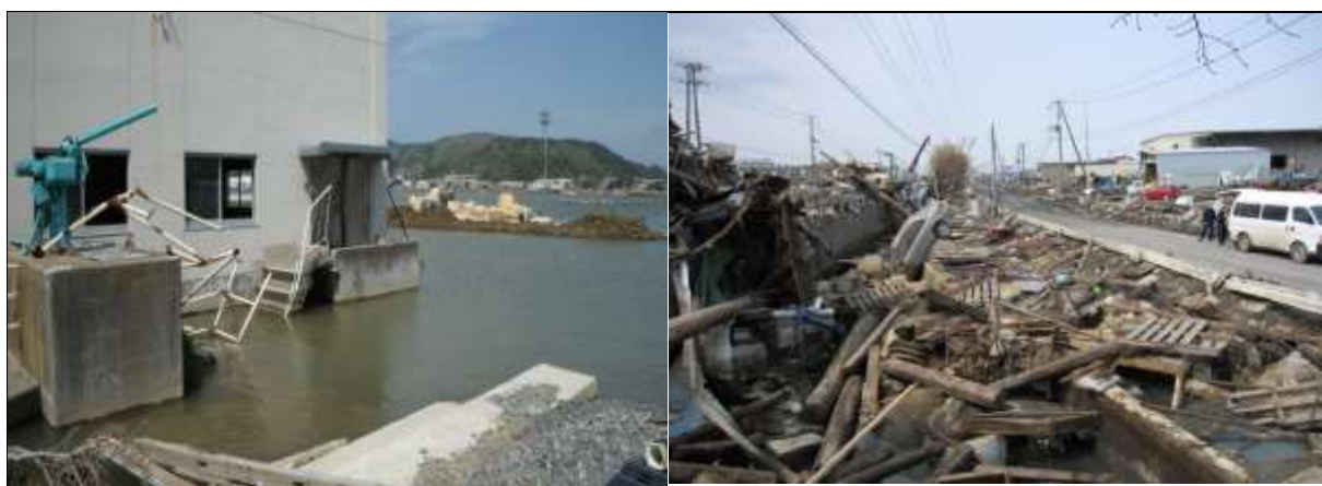
図 2-6 雨水施設の被害状況
