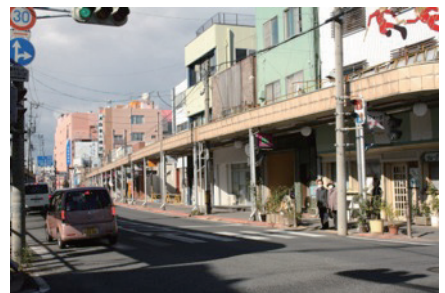
【事例：アーケード撤去と街路灯の設置によるまちづくり、石巻市】
