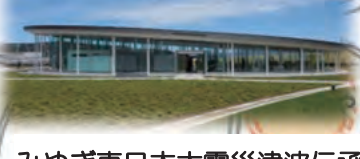
みやぎ東日本大震災津波伝承館
