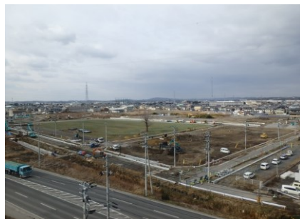
▲造成工事状況
