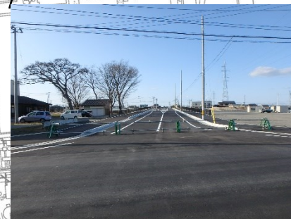
[道路築造完了]
