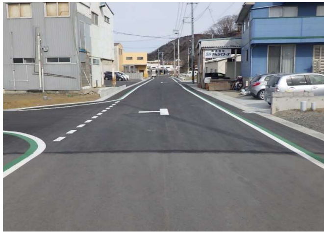
【道路舗装完了】
