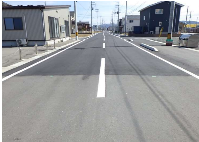
【道路舗装完了】
