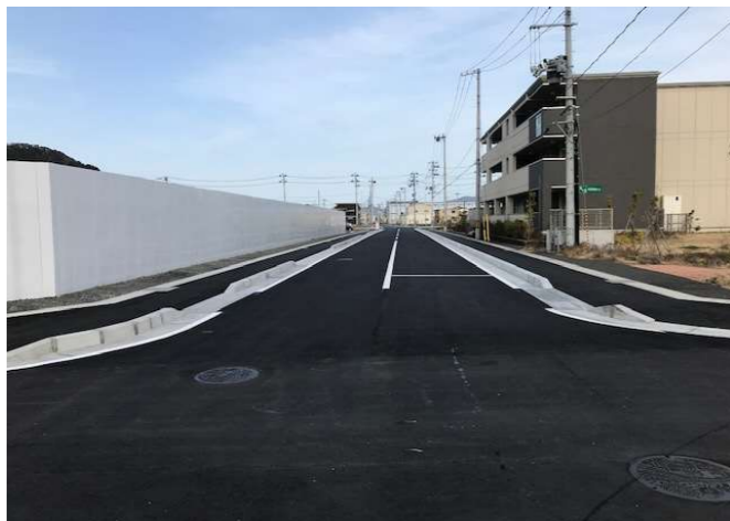
【道路舗装完了】
