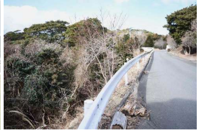
写真 3-2 避難路上流部（浄化センター付近）の現況
