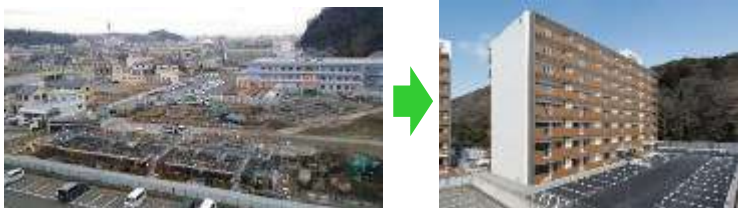
吉野町一丁目地区 工事状況
