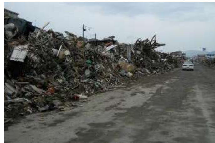
▲南浜町の被災状況(3月21日撮影)
