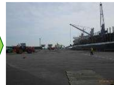
石巻港雲雀野埠頭 地盤沈下の復旧状況
