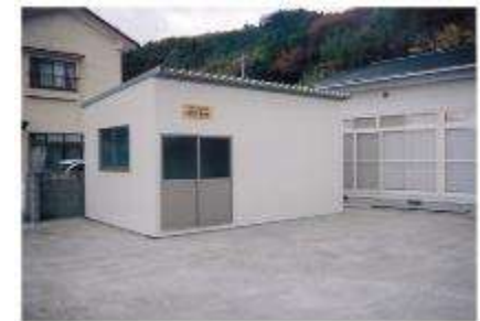
自主防災組織が整備した防災備蓄倉庫
