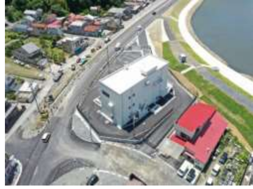
完成後（令和 3 年 3 月）
