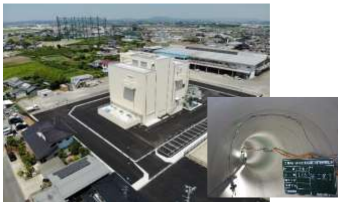
完成後（令和 3 年 6 月）
