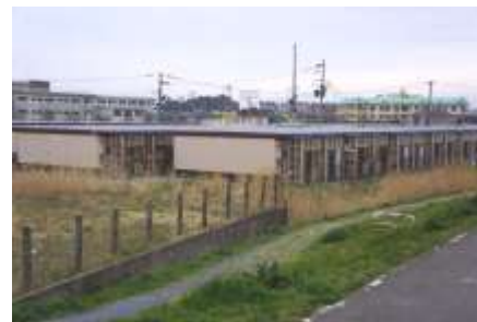
拠点箇所は現在仮設住宅が立地している
