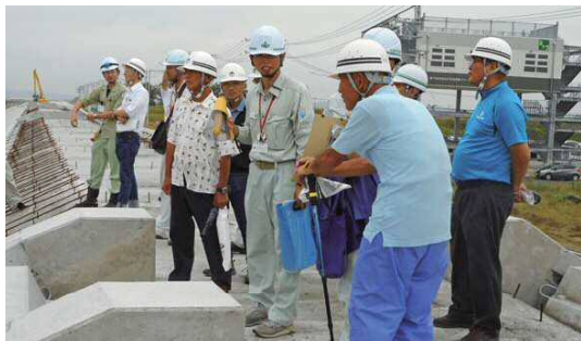
普段上れない工事中の西浜防潮堤を見学
