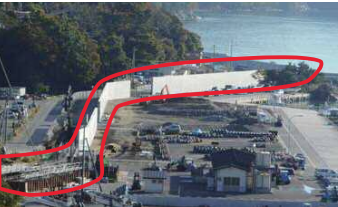
復旧延長301.7mの防潮堤工事を進めています。復旧にあたりT.P.+6.0mの高さとしています。
