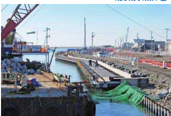
棧橋と護岸の復旧工事を進めており、平成30年3月の完成を予定しています。
