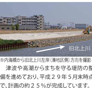
※内海橋から旧北上川左岸（湊地区側）方向を撮影 津波や高潮からまちを守る堤防の整備を進めており、平成29年5月末時点で、計画の約25%が完成しています。
