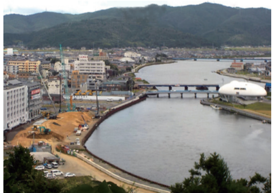
↑日和山から見た旧北上川沿いの工事状況（平成28年8月撮影）
