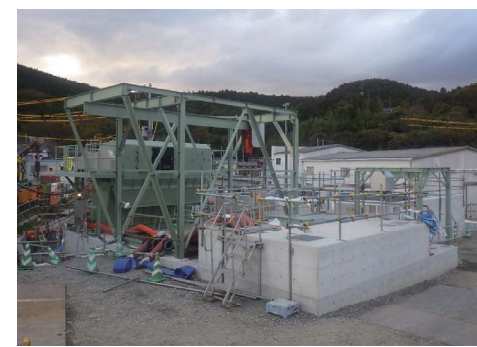
折立第三排水ポンプ場(施工中)
