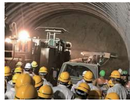
トンネル工事(コンクリート吹付)を見学
