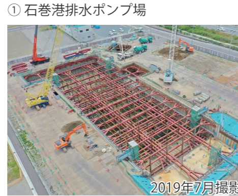
① 石巻港排水ポンプ場
