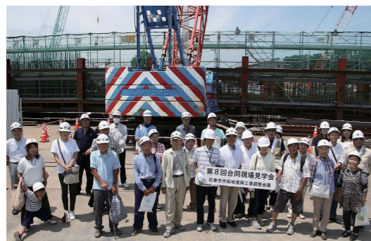
石巻中央排水ポンプ場
