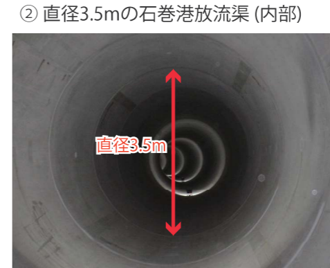
② 直径3.5mの石巻港放流渠(内部)
