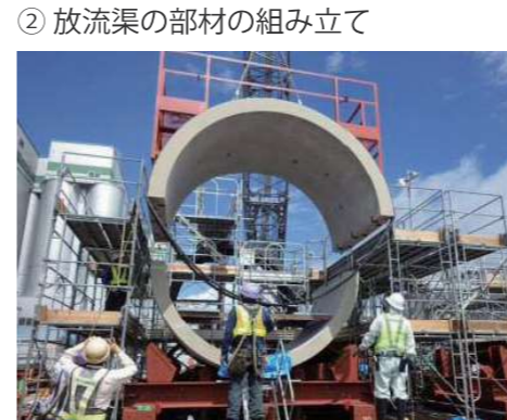
② 放流渠の部材の組み立て
