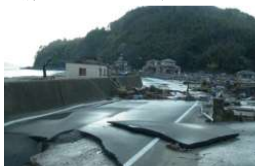
▼断絶した北上地区の道路
