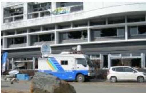
▼被災した雄勝総合支所
