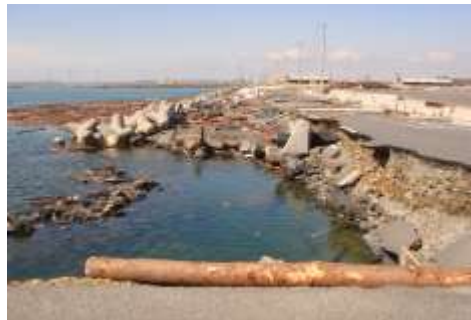
▼被災した雲雀野海岸堤防
