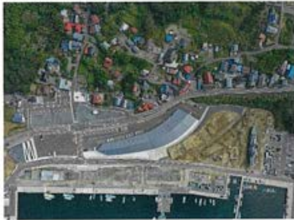
<建築工事完了後>
