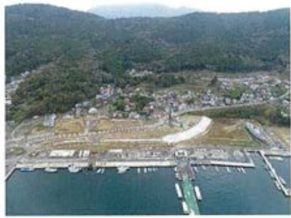
<造成工事暫定完了後（建築着手）>
