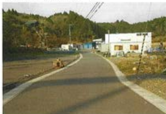
<整備後（集落道）>
