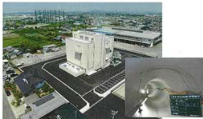
完成後（令和 3 年 6 月）
