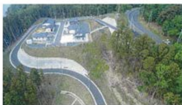
完成した移転団地
