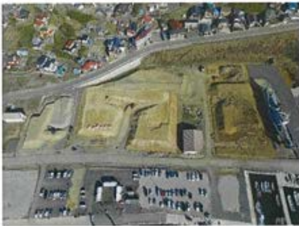
<造成工事着手前>
