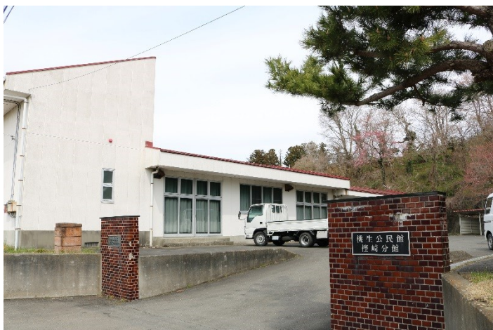
石巻市桃生公民館榎崎分館
