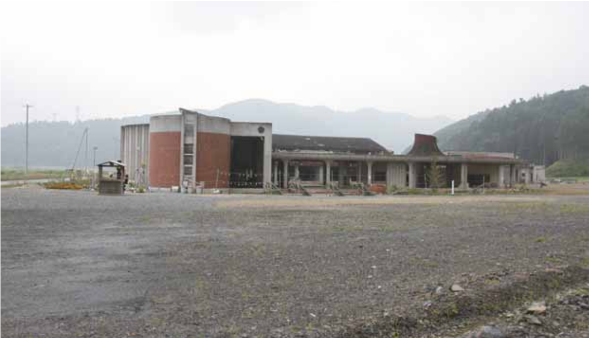
▲震災遺構として保存が決まった大川小学校旧校舎
