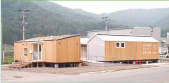
施設はトレーラーハウス3棟(管理棟、交流棟、情報展示棟)で構成しています。
