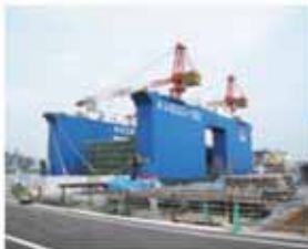
▲上の写真は、泊漁港で用いられるケーソンです。高さ9メートル、重さ約700トンの大きさです。(8月撮影)ケーソンは、フローティングドックという海上に浮かんだ設備で製作されます。(写真の青い部分がフローティングドック)製作が完了すると、ドック自体を沈ませて完成したケーソンを引き出します。
