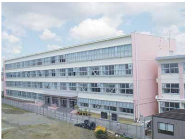
▲大規模改修された西棟
