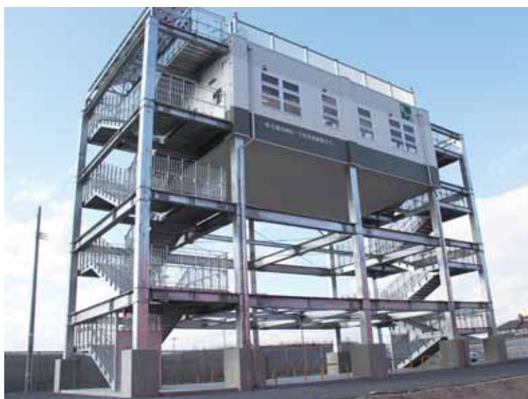
▲魚町一丁目津波避難タワー
