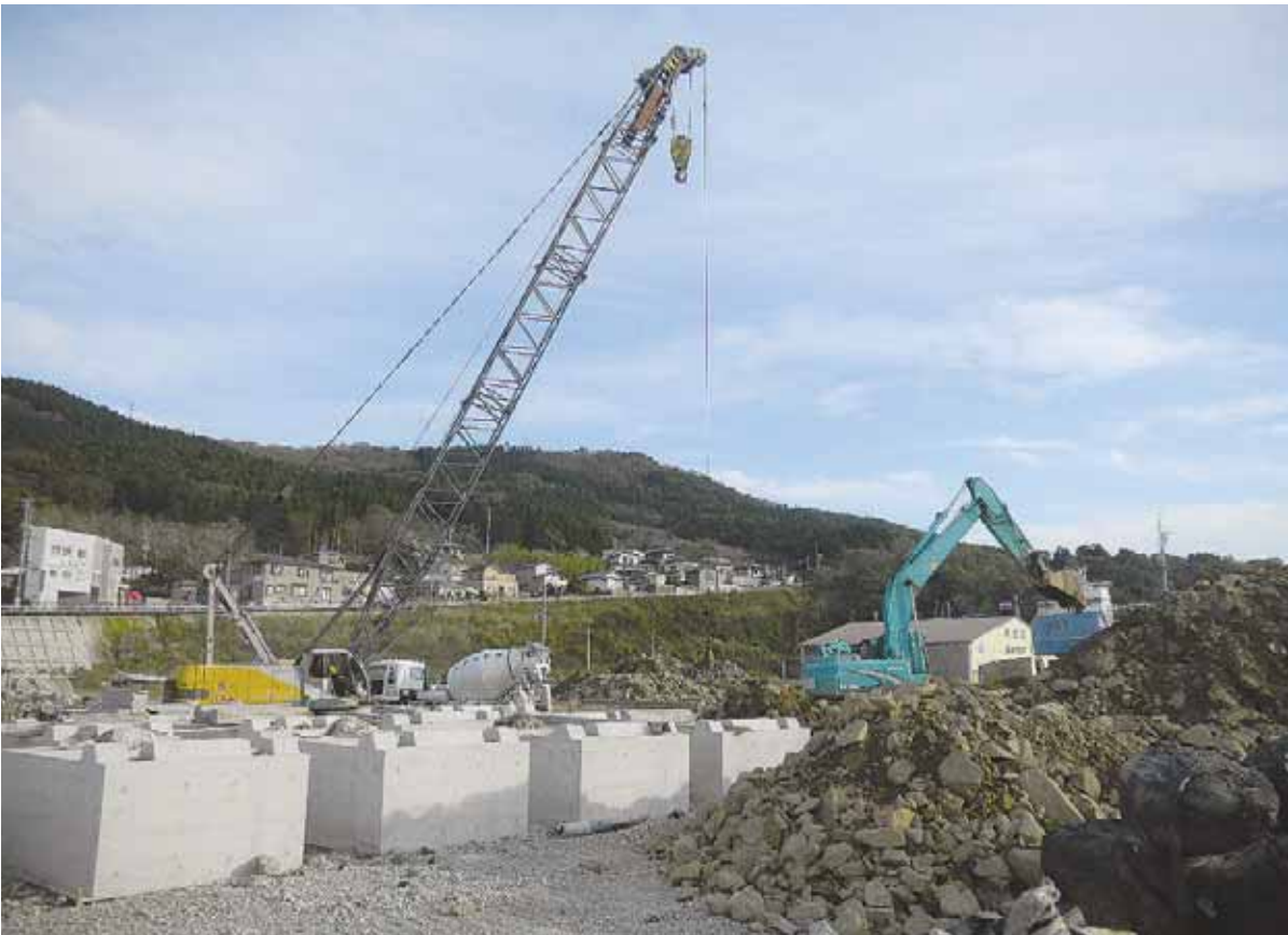
▲鮎川港工事（県直轄）
