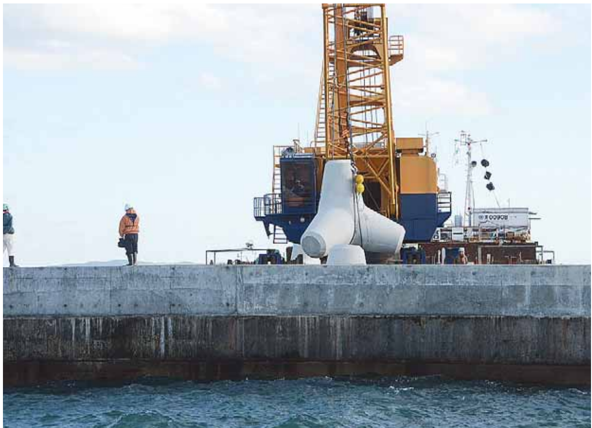
▲南防波堤テトラポット設置（国直轄）
