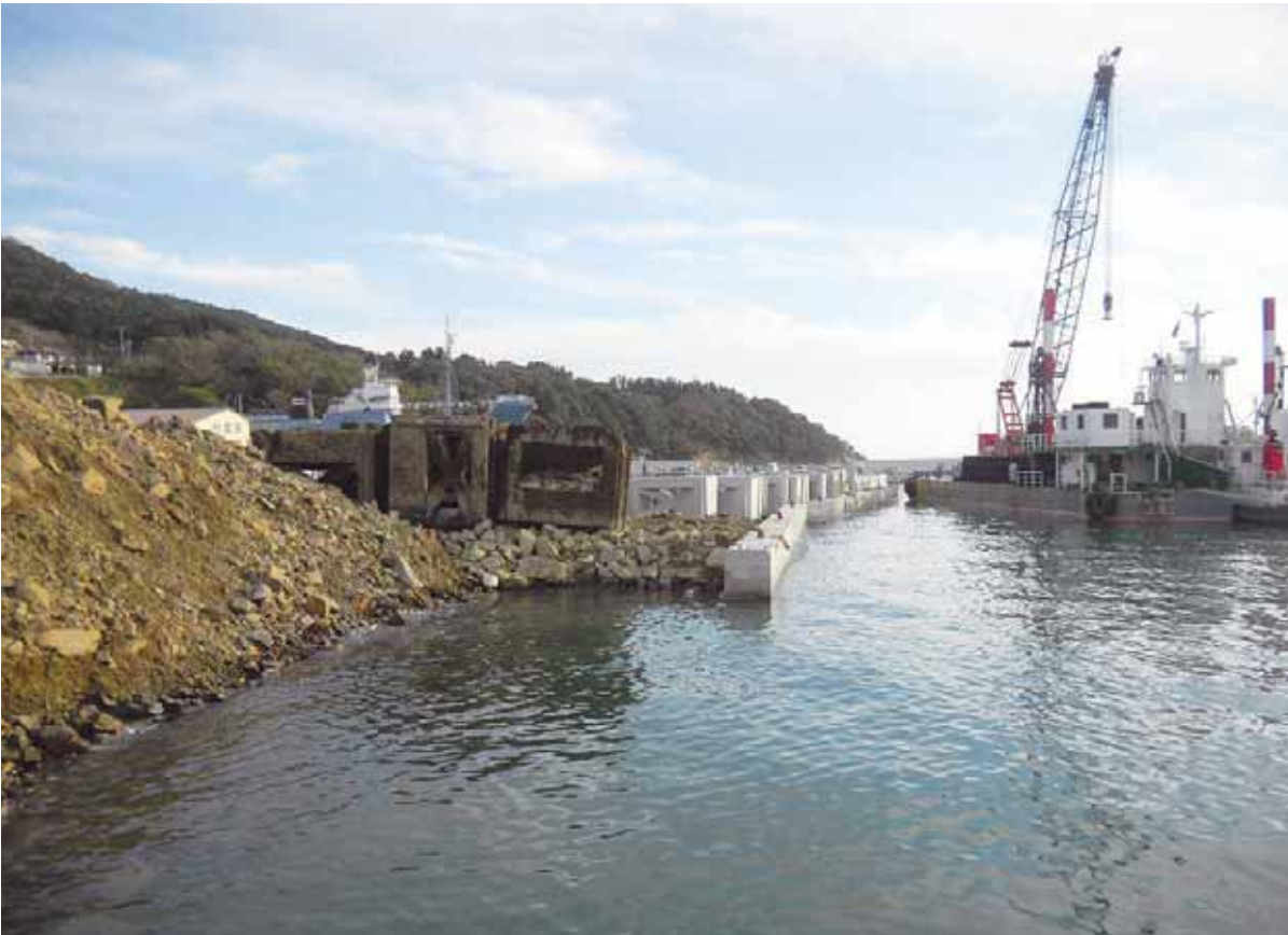
▲鮎川港工事（県直轄）
