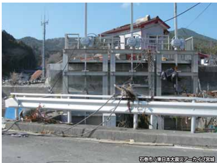
石巻市//東日本大震災アーカイブ宮城 ▲荻浜田ノ浜山 荻浜中学校
