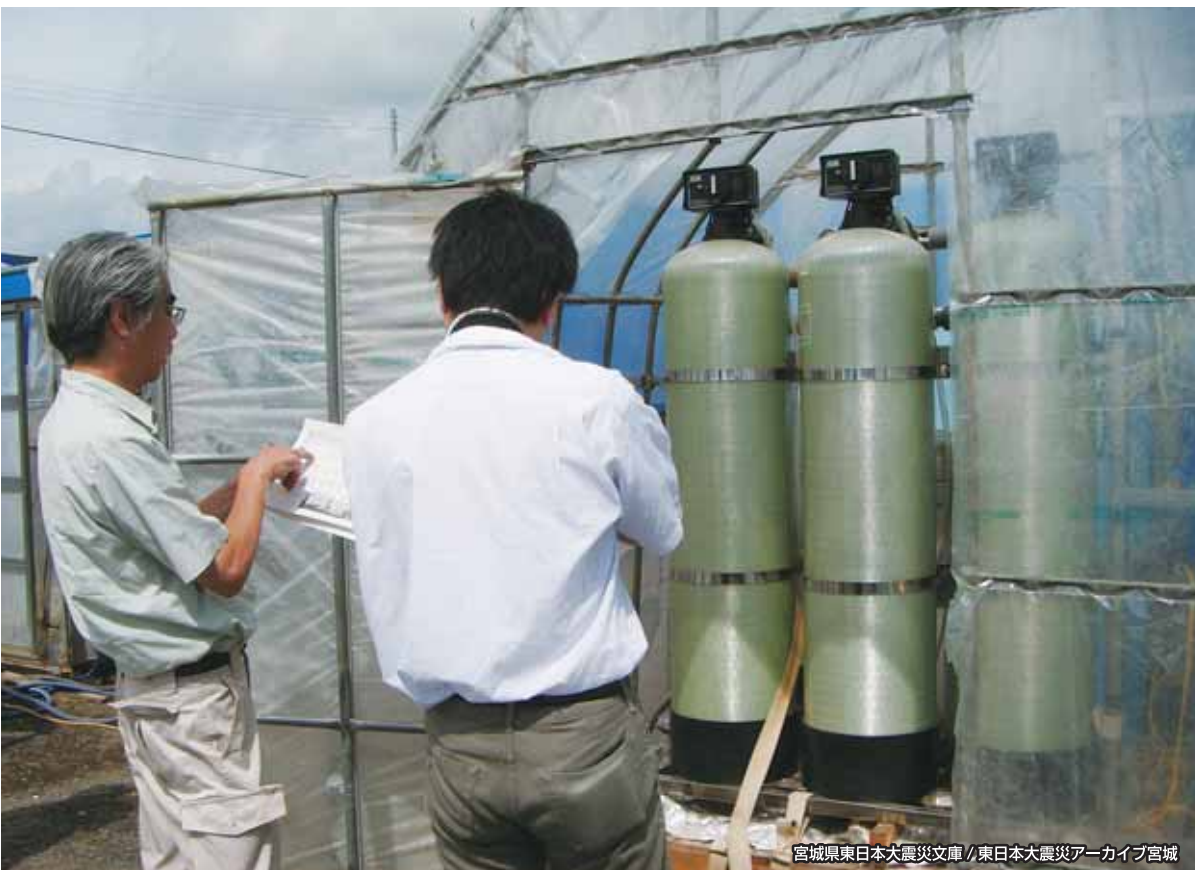
▲蛇田地区 地下水ろ過装置(平成24年(2012)9月5日)
