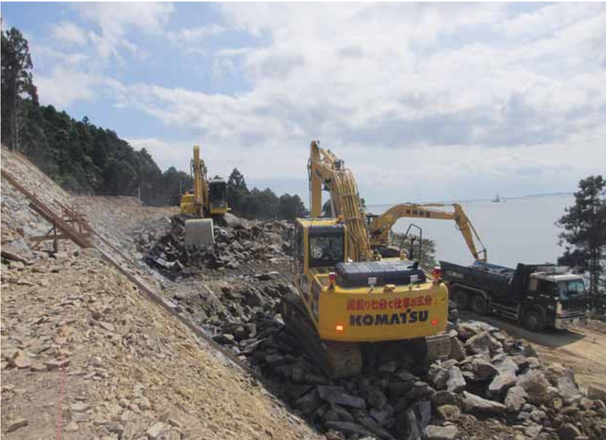
▲小竹浜線掘削除工
