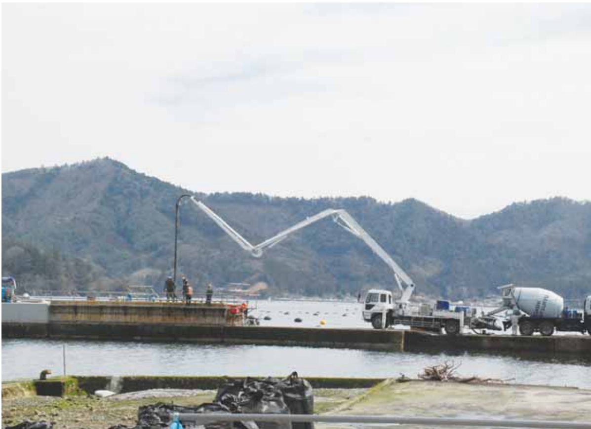
▲水浜漁港復旧工事
