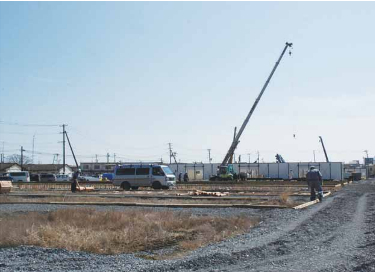
▲仮設住宅建設（向陽町）
