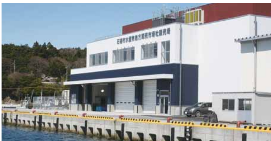
▲水産物地方卸売市場牡鹿売場・牡鹿製氷冷蔵庫
