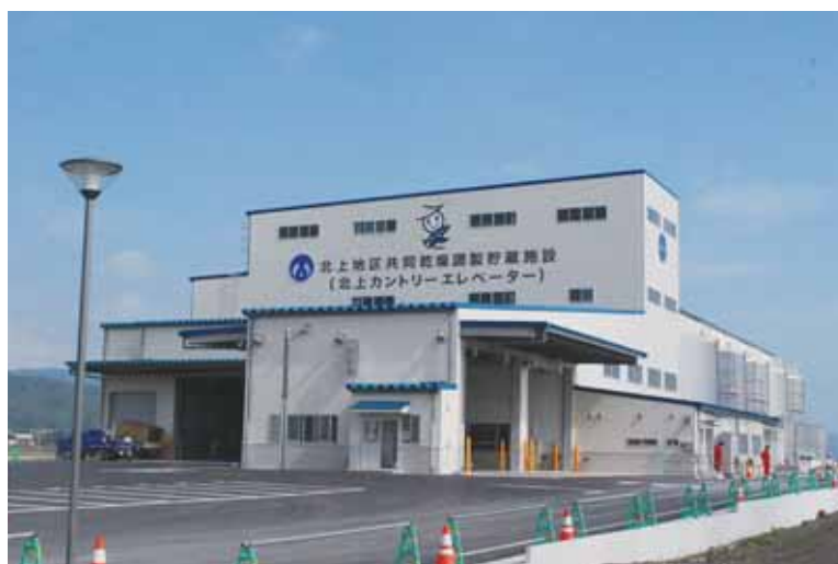
▲北上カントリーエレベーター
