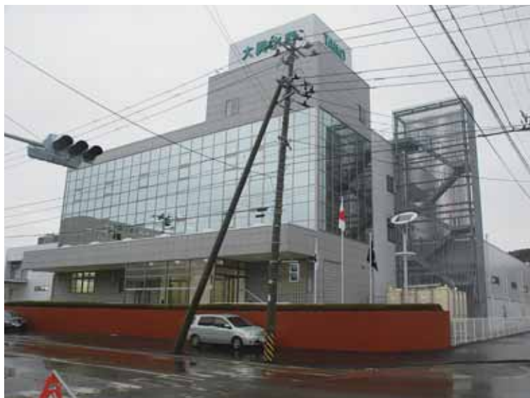
▲津波避難ビル認定第1号(大興水産)
