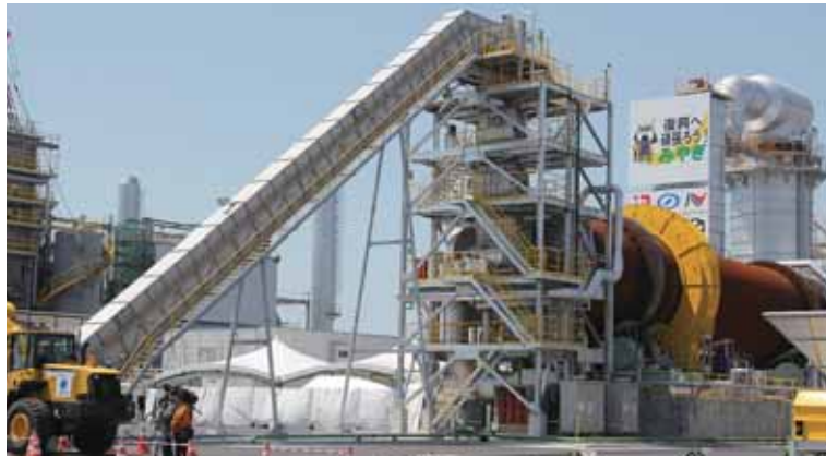
▲災害廃棄物処理施設 火入れ
