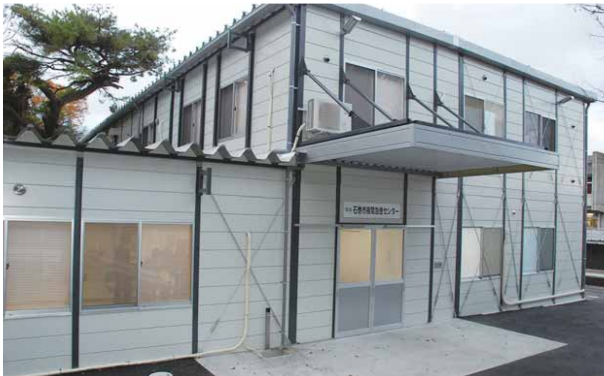
▲仮設夜間急患センター
