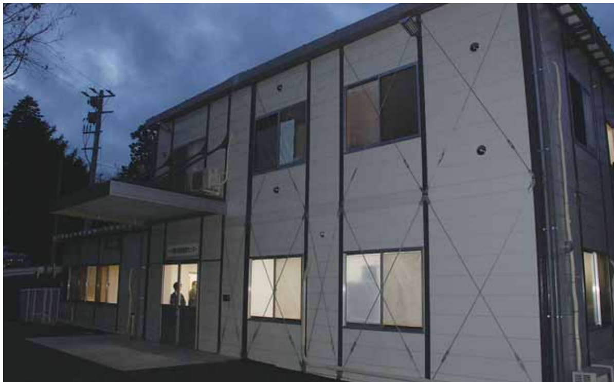
▲仮設夜間急患センター
