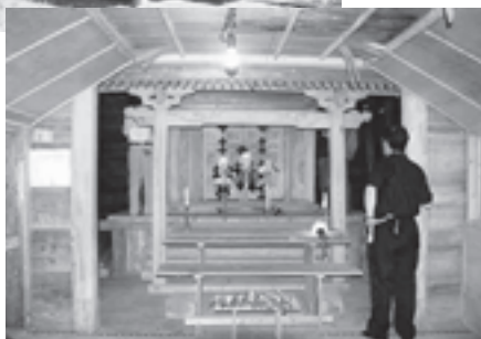
▶覆屋の中の本殿
